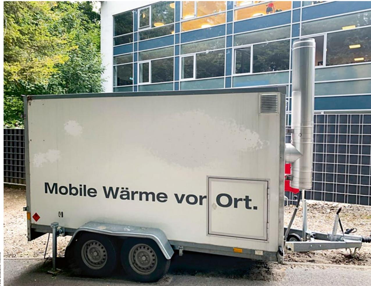
Eine mobile Heizzentrale mit 5000-Liter-Reservetank und installiertem Brenner ist von der SV betroffen.
